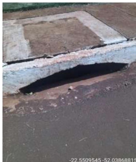
Figura 31- Bocas de lobo (A) Com grade (B) Sem grade
