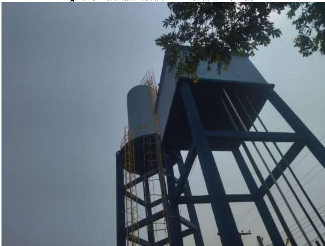
Figura 25- Reservatórios da SAMAE de Jardim Olinda/PR.
