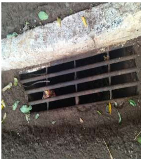
Figura 31- Bocas de lobo (A) Com grade (B) Sem grade
