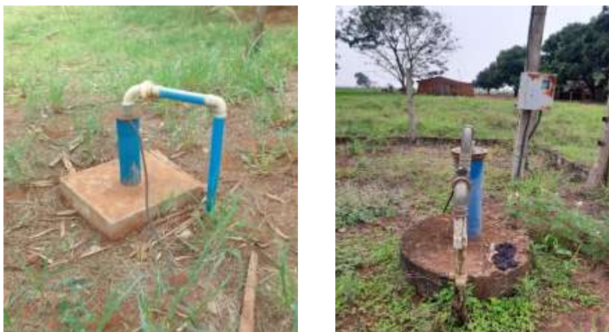
Figura 44 – (A) Poço 3 (B) Poço 4.
