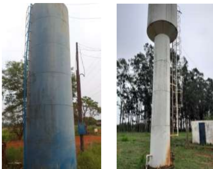
Figura 46 – (A) Reservatório 3 (B) Reservatório 4.
