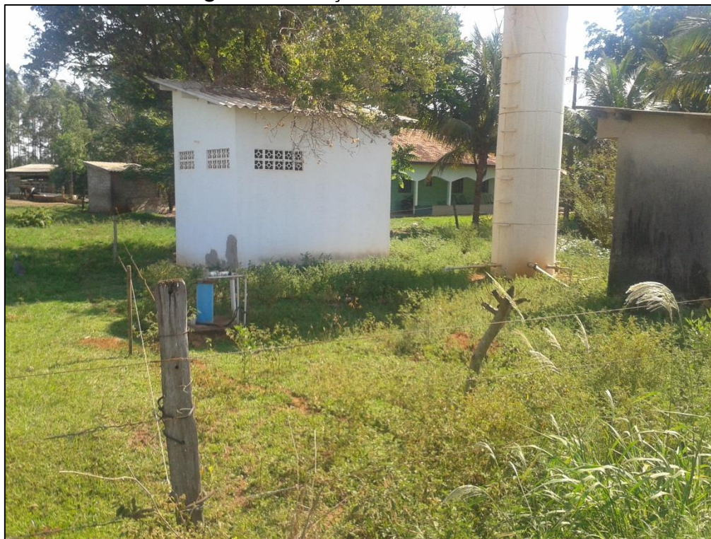
Figura 3.7- Poço do assentamento.
