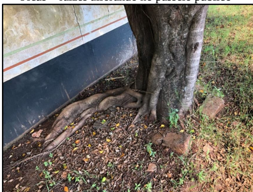
Figura 9. Problemas encontrados com a espécie Ficus – raízes aflorando no passeio público
