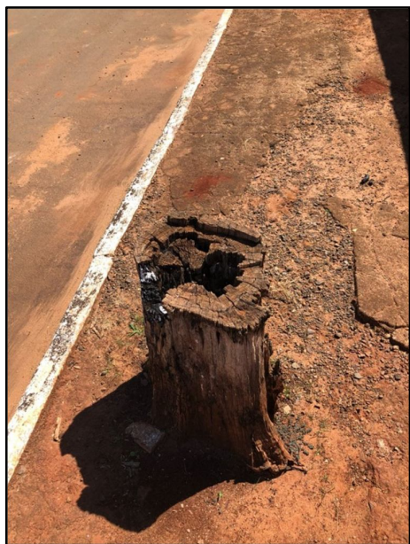
Figura 28. Tronco não retirado.
