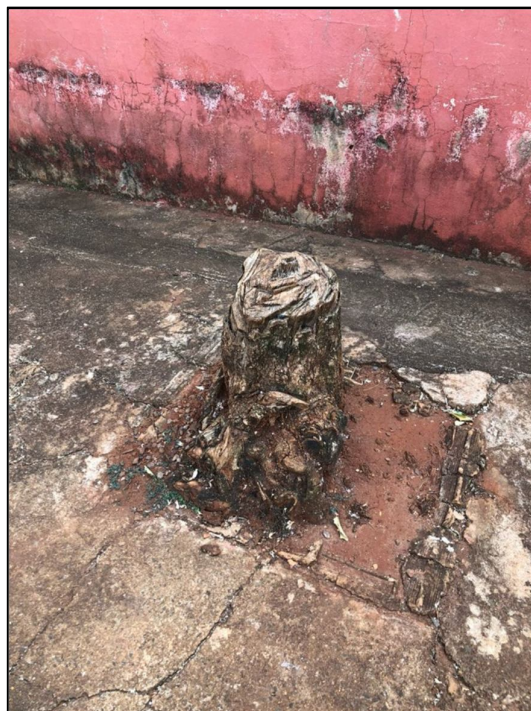
Figura 31. Tronco não retirado.
