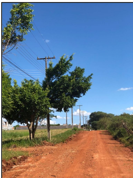
Figura 11. Problemas encontrados com a espécie Ficus – Copa muito densa – Problemas com fiação
